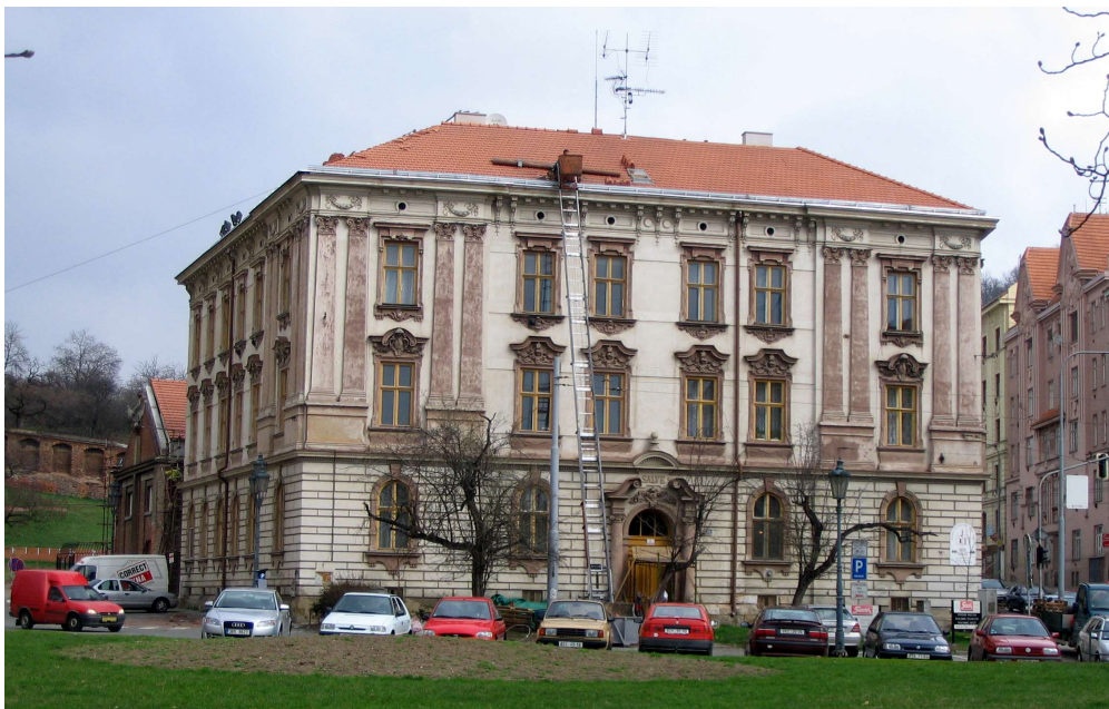
Obr. 3: Situace Mendlovo náměstí v Brně: Závěrečná fáze opravy zastřešení domu Salve (fotoarchiv Čechová)
