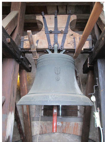
Obr. 23: Konstrukce zvonové stolice – zvonové patro věže kostela ve výšce 17,93 m formou prostorového modelu [5], vlevo jeden ze zvonů kostela ve Vrahovicích - zvon z roku 1586 od mistra Georga Ieghpergera, hmotnost cca 1450 kg (fotoarchiv Čechová).
