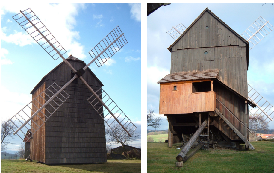
Obr. 18: Větrný mlýn v Partutovicích: vlevo pohled na severní stranu s větrným kolem, vpravo pohled na jižní stranu mlýna se šalandou a přístupovým schodištěm (fotoarchiv Prokop, Čechová)
