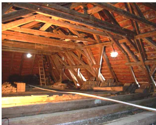
Obr. 11: Vlevo pohled do dostavěné části krovu kostela s valbou, vpravo původní část krovové konstrukce lodi kostela (fotoarchiv Čechová)
