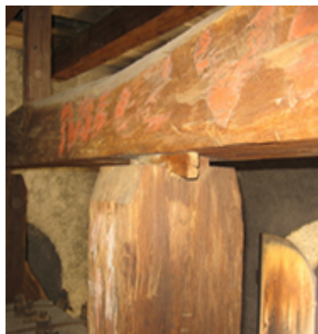
Obr. 24: Konstrukce zvonové stolice s lokalizací poškození v prostorovém modelu [5], vpravo fotodokumentace horního příčného trámu (prohnutí nahoru, uvolnění ze spojů vlivem namáhání konstrukce – pravidelný kyv zvonů, v 3D označeno žlutě). Poškozeny jsou dvě šikmé vzpěry, příčný trám a část podlahových prken (v obrázku vlevo není zaznamenáno).
