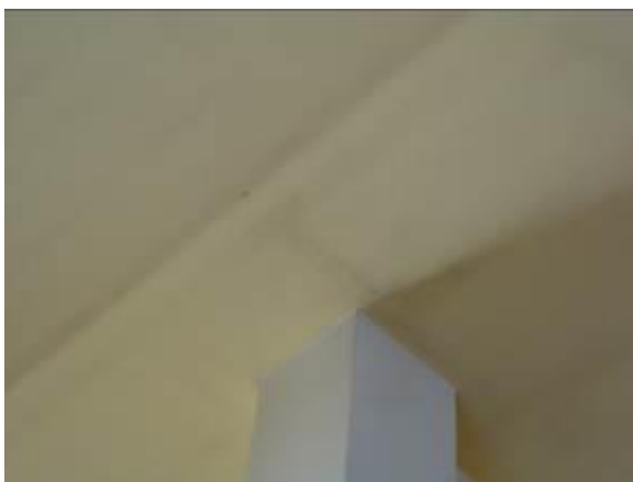
Obr. 6: Prorýsování nosné konstrukce na povrchu sádkartónu v interiéru nad kamny
