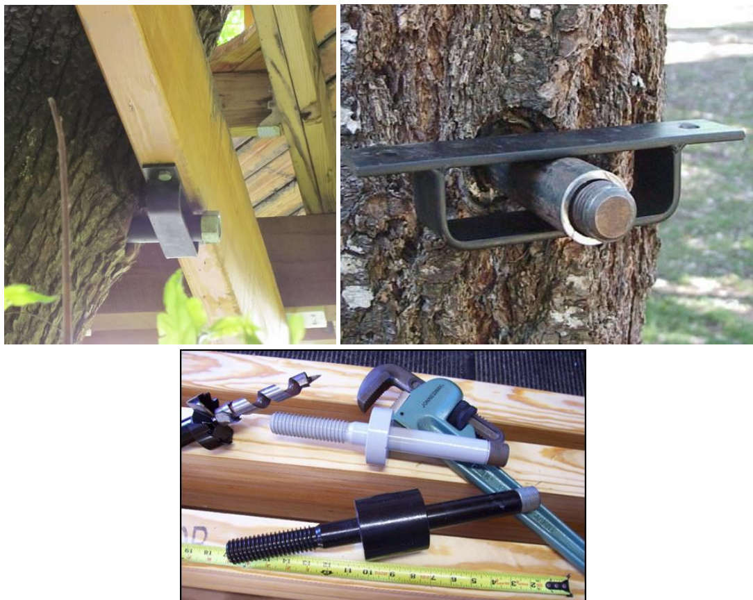
Obr. 1: Speciální šroubovací kotva a zabudovaný kotevní systém-tzv. flexibilní podpora, potřebné nářadí – obrázek dole [4].
