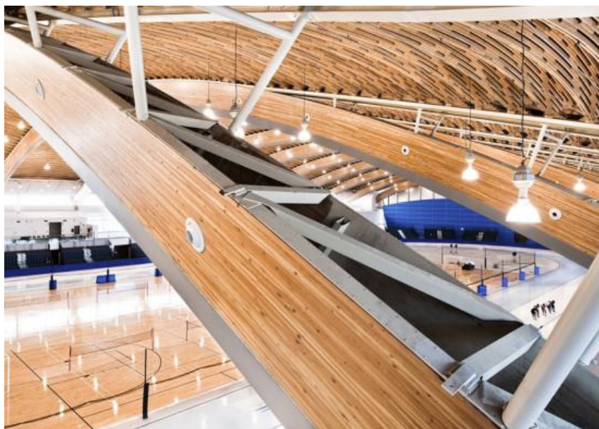
Obr. 12: Detailní pohled na kombinovanou konstrukci nosníků [25]
