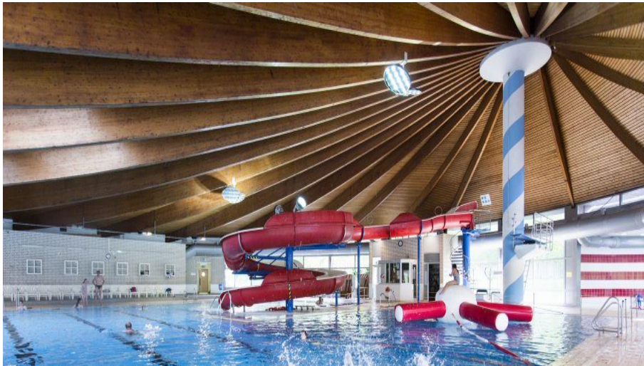
Obr. 18: Zastřešení bazénu Barsinghausen - průměr 42 m, závěsné lepené nosníky [29]
