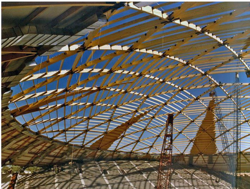
Obr. 13: Montáž zastřešení haly Skydome (kopule) v roce 1977, průměr 153 m, 1977, Flagsaff, Arizona, USA [26]
