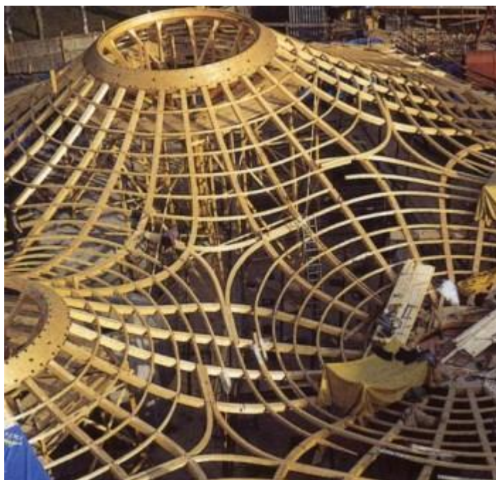
Obr. 17: Žebra dřevěné střešní konstrukce konstrukce - Bad Dürreim [30]
