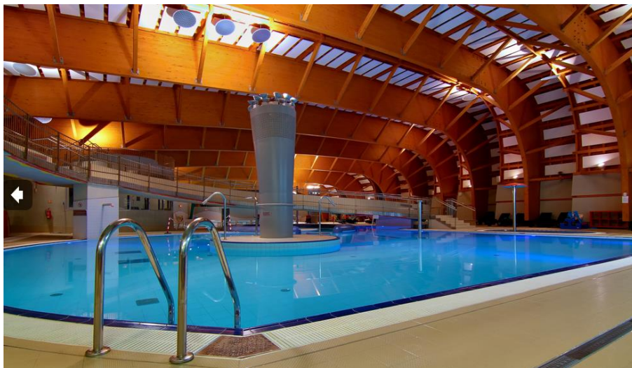
Obr. 7: Bazénová hala v Brně – Kohoutovicích [19]
