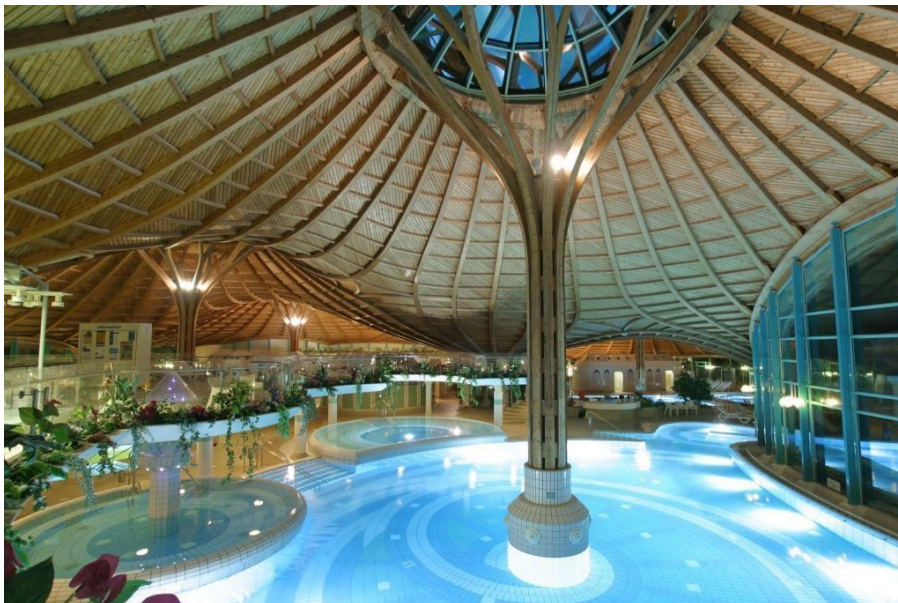
Obr. 16: Žebrová skořepina – zastřešení solánkové lázně, 1987, Bad Dürreim, Německo [28]
