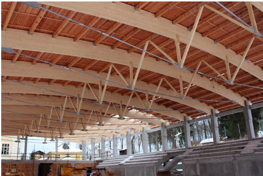
Obr. 8: Multifunkční hala v Kašperských horách (realizace 2015) - lepené obloukové vazníky s ocelovým táhlem a s dřevěnou vzpěrou. [20]
