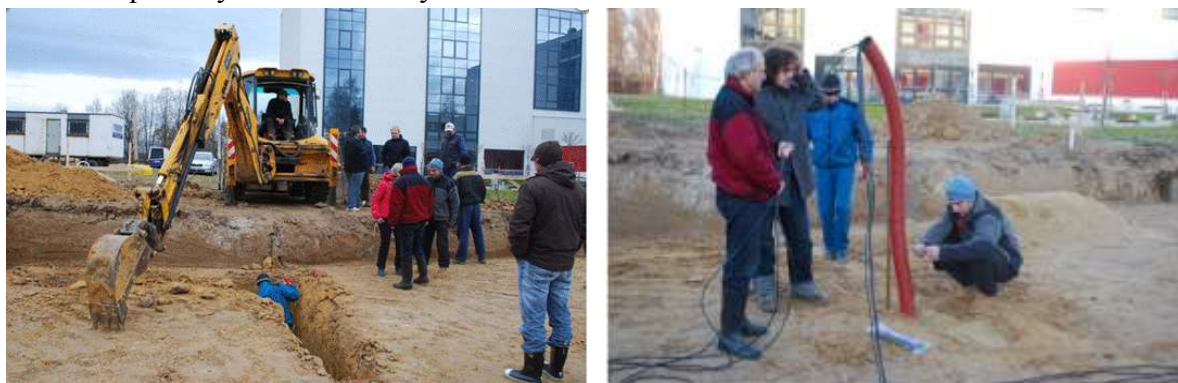
Obr. 1.4 Realizace umístění teplotních čidel do zeminy v podzákladí dřevostavby
