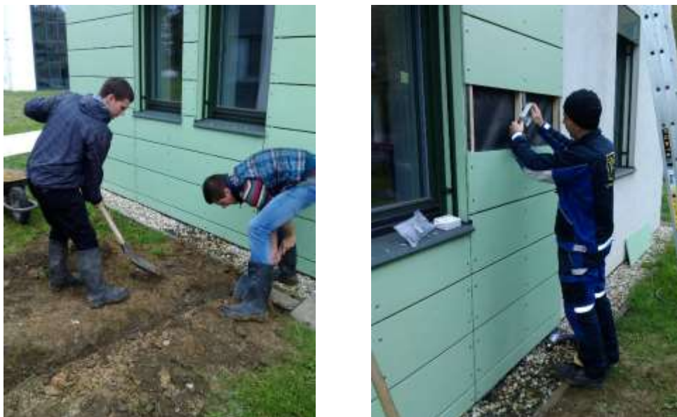
Obr. 1.7 Realizace umístění teplotních čidel do zeminy mimo budovu dřevostavby
