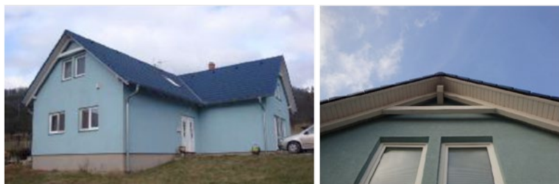
Obr. 1 a 2: Dřevostavba postavená v roce 2004 - čelní pohled na stavbu. Detail přesahu střechy.
