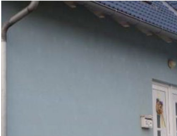
Obr. 5: Prorýsování kotev zateplovacího systému na fasádě
