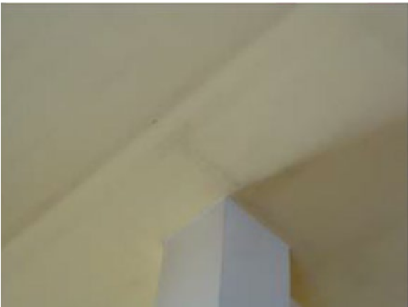
Obr. 6: Prorýsování nosné konstrukce na povrchu sádrokartonu v interiéru nad kamny
