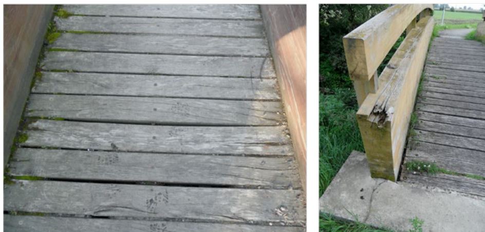
Obr. 22 a 23: Zanedbaná údržba – v mezerách mostovky se zachytily nečistoty i vegetace, degradace nosného prvku.
