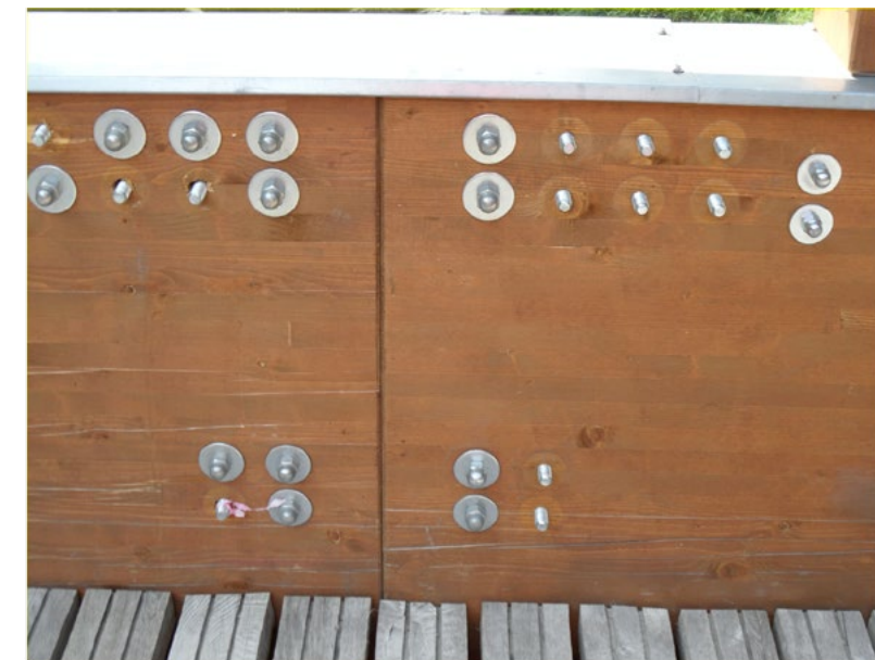
Obr. 34: Chybějící podložka a matice
