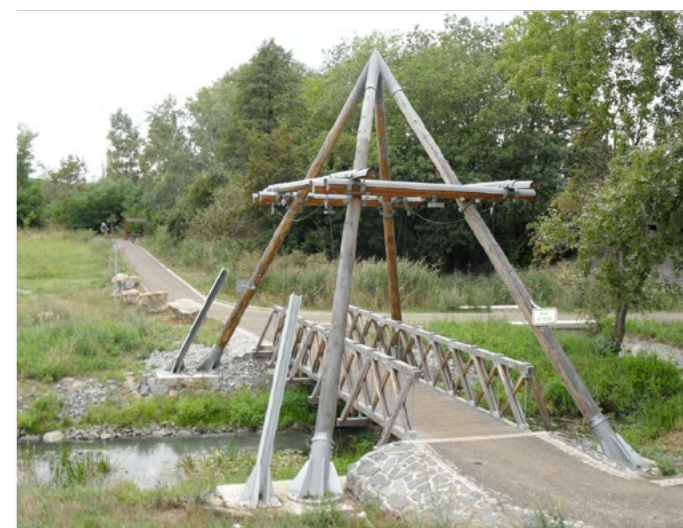
Obr. 2: Zvedací lávka na cyklostezce v Mladé Boleslavi byla navržena kvůli hrozbě povodní. Mechanismus umožní v případě hrozící velké vody konstrukci zvednout do výšky.
