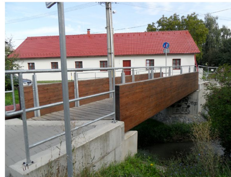
Obr. 5: Dvojice přímých plnostěnných prostých nosníků z lepeného dřeva s dolní mostovkou
