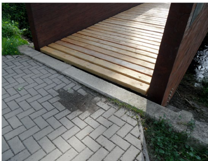
Obr. 22: Vyměněná mostovka prodlouží životnost lávky
