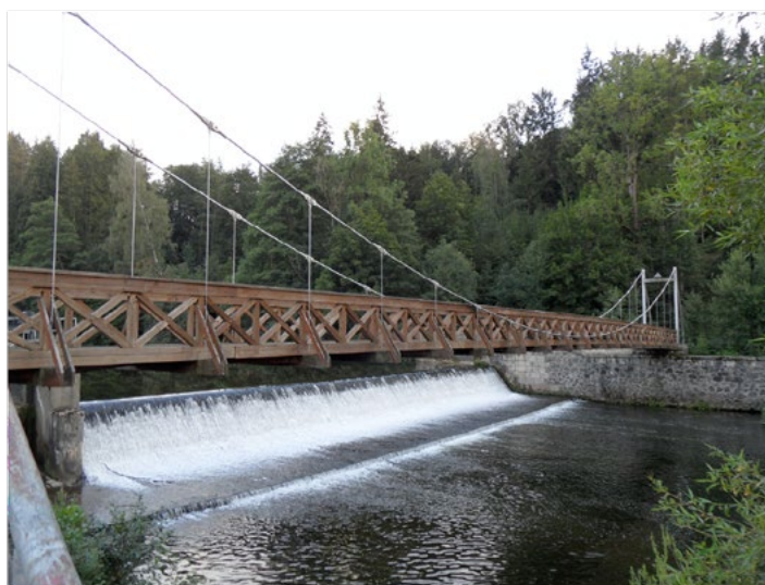
Obr. 16: Visutý most s výztužným nosníkem
