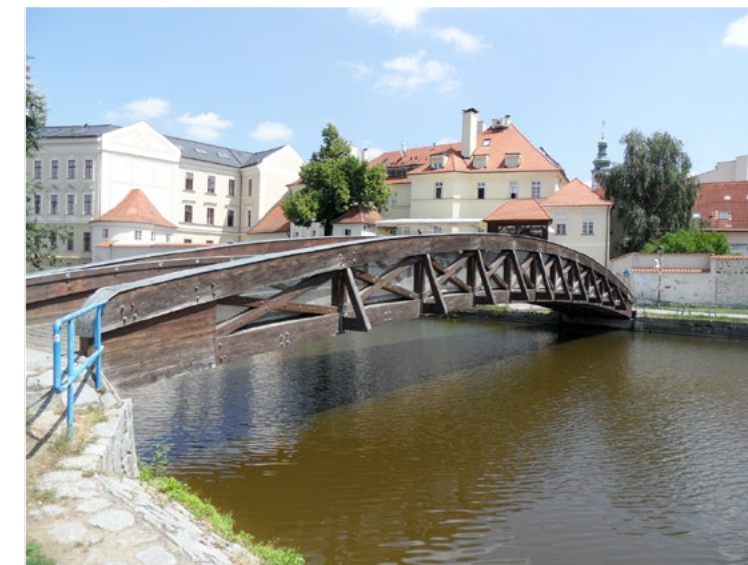
Obr. 10: Příhradový oblouk (oblouky srpovitého tvaru)
