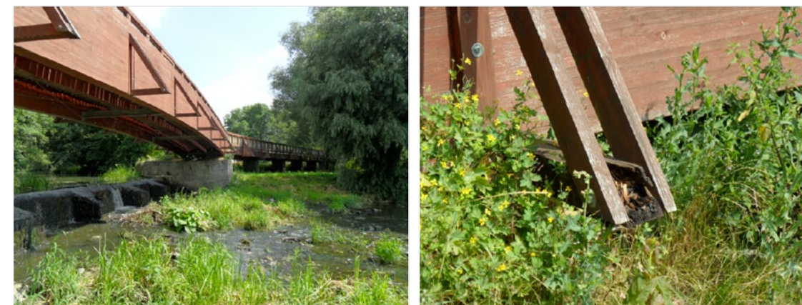
Obr. 19 a 20: Architektonicky zajímavý prvek – avšak biologické poškození vodorovného prvku z rostlého dřeva. Koncová vlákna jsou vystavena povětrnostním vlivům.
