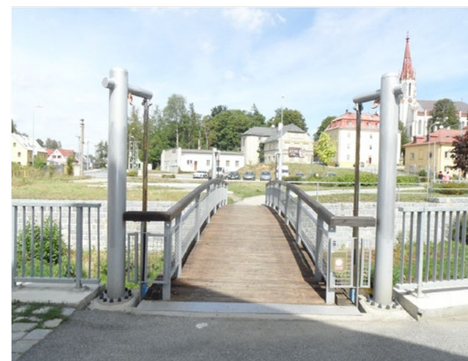
Obr. 1: Lávka se zvedacím mechanismem v Chrástavě - na březích je upevněná vždy na dvou sloupech, po nichž se může posouvat nahoru a dolů, aby při povodních netvořila bariéru.
