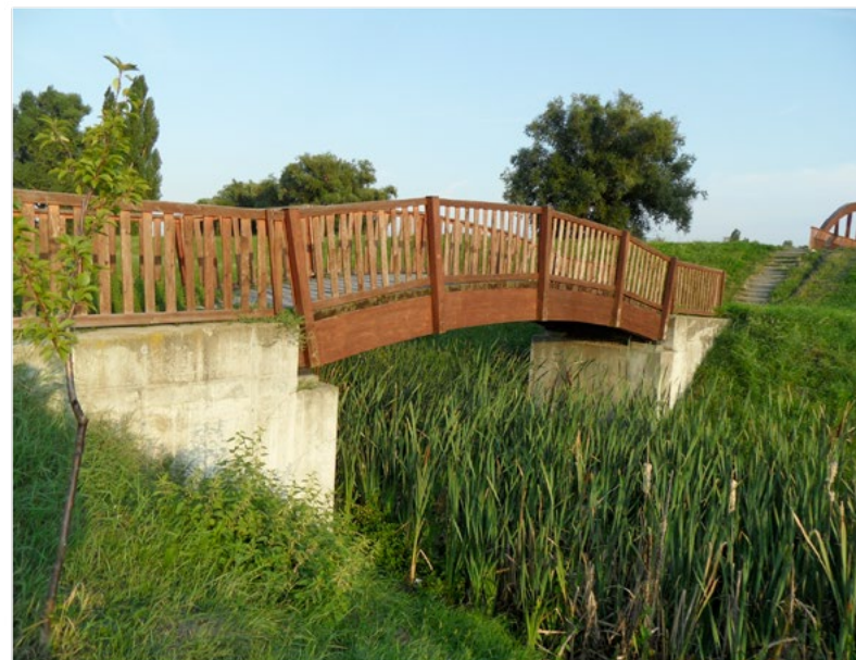
Obr. 8: Dvojice obloukových plnostěnných prostých nosníků z lepeného dřeva s horní mostovkou
