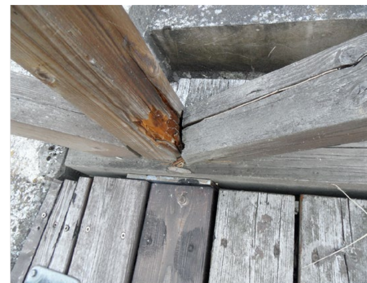
Obr. 23: Nevhodný konstrukční detail způsobuje degradaci dřeva - voda zatéká do spoje.
