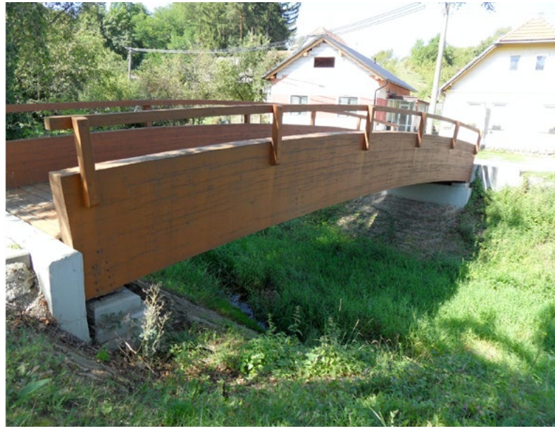
Obr. 7: Dvojice obloukových plnostěnných prostých nosníků z lepeného dřeva s dolní mostovkou
