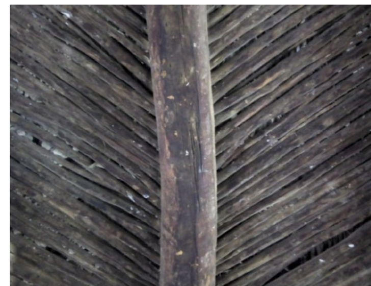
Obr. 10: Dřevěná stropní konstrukce
