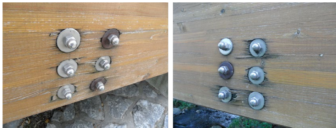
Obr. 31 a 32: Nekrytý svorníkový spoj a nadměrné dotažení svorníků
