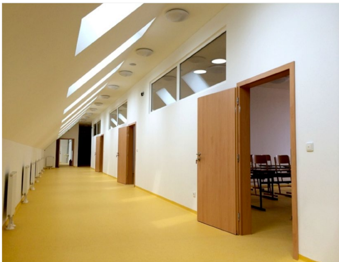
Obr. 8: Foto ze stavby – Varianta 3B - 411-7 Kmenová učebna – fotografie nově vzniklé půdní vestavby, průhled do učebny s viditelnými světlovody (zdroj: https://www.senkyrik.cz/fotogalerie#1308 )
