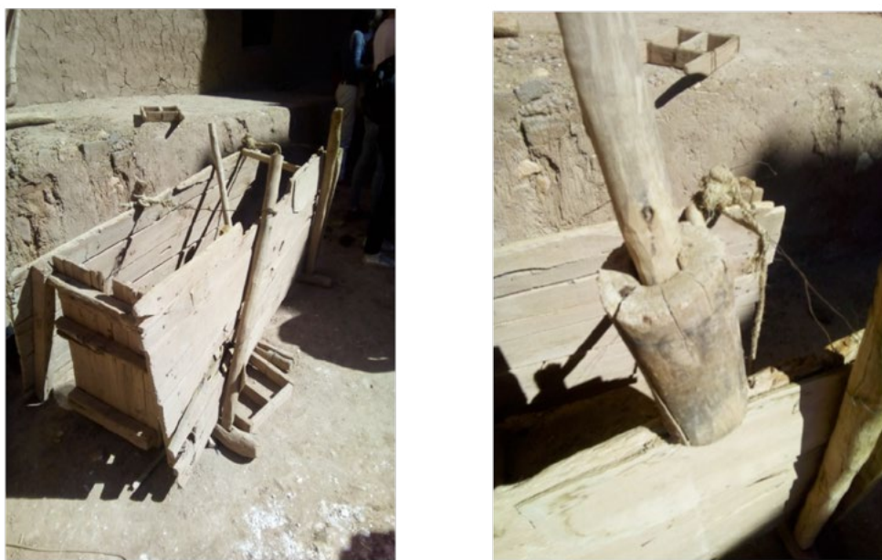
Obr. 4 a 5: Bednění a dusadlo pro výrobu dusaných hliněných stěn.
