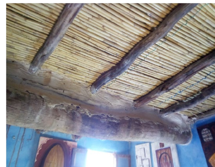
Obr. 11: Styk průvlaku a stropních nosníků se záklopem z plošně vyskládaných klacků.
