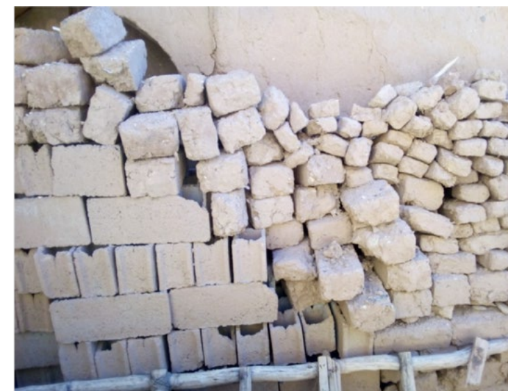
Obr. 2: Nepálené cihly různého formátu. Vlevo jde vidět imitace. Bednicí tvarovka z betonu povrchově potřena řídkou hliněnou směsí („špryc“).
