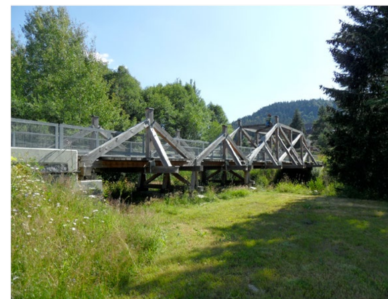
Obr. 14: Věšadlový most – kombinace jednoduchých a dvojnásobných věšadel
