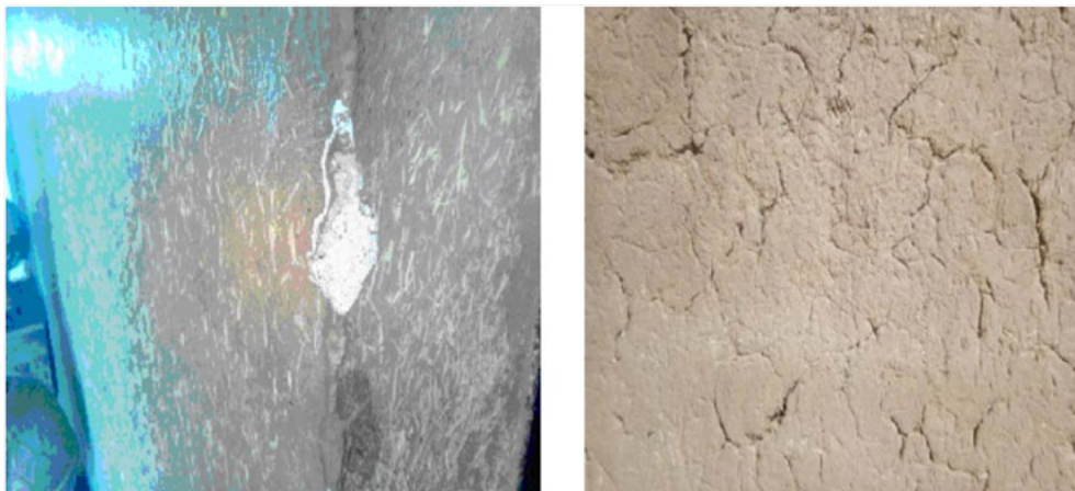
Obr. 1: Napodobenina hliněné omítky - silikát s příměsí řezanky. Obr. 3: Hliněná omítká
