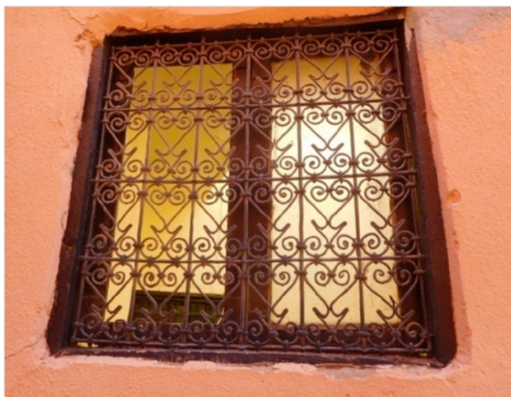
Obr. 18: Kované mříže oken.
