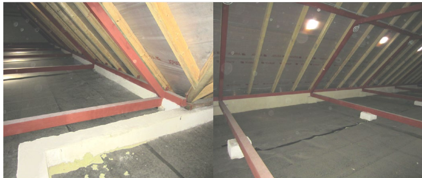
Obr. 1: Pohled na uložení ocelových ráků podélné části krovu
