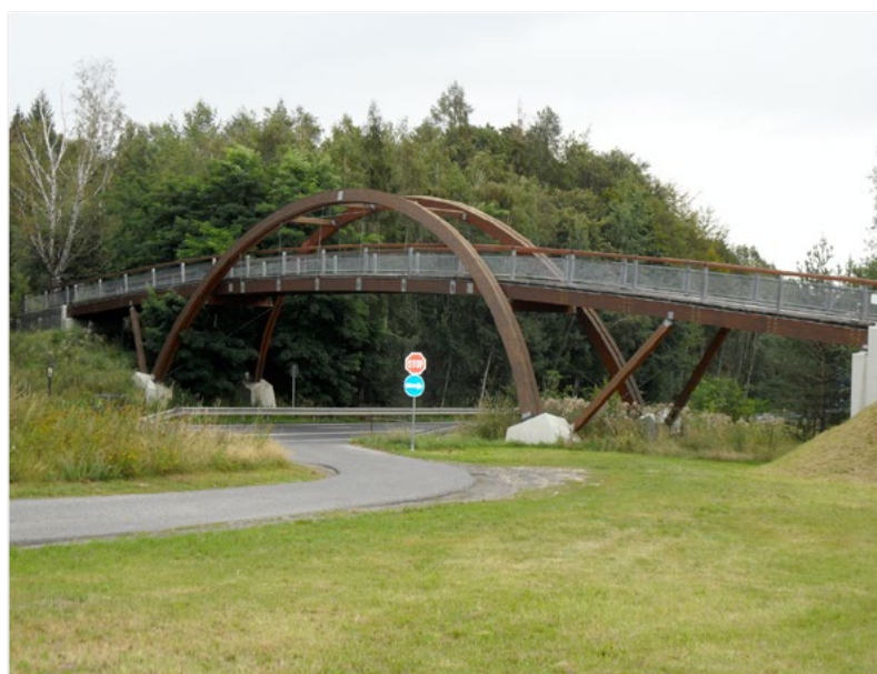
Obr. 12: Obloukový most s mezilehlou mostovkou - plnostěnný oblouk z lepeného dřeva
