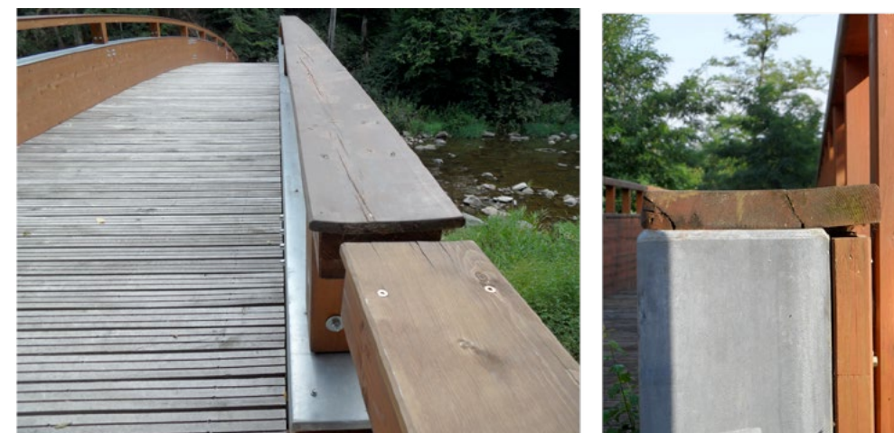
Obr. 26 a 27: Krycí desky zábradlí jsou osazeny nesprávně, tudíž neplní svoji funkci, voda po deštích se zde může hromadit – neodtéká.
