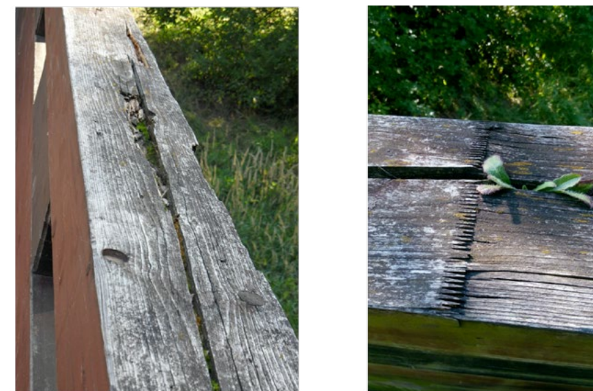
Obr. 24 a 25: Výsušné trhliny zábradlí z rostlého i lepeného dřeva se zanáší a do dřeva proniká více vlhkosti
