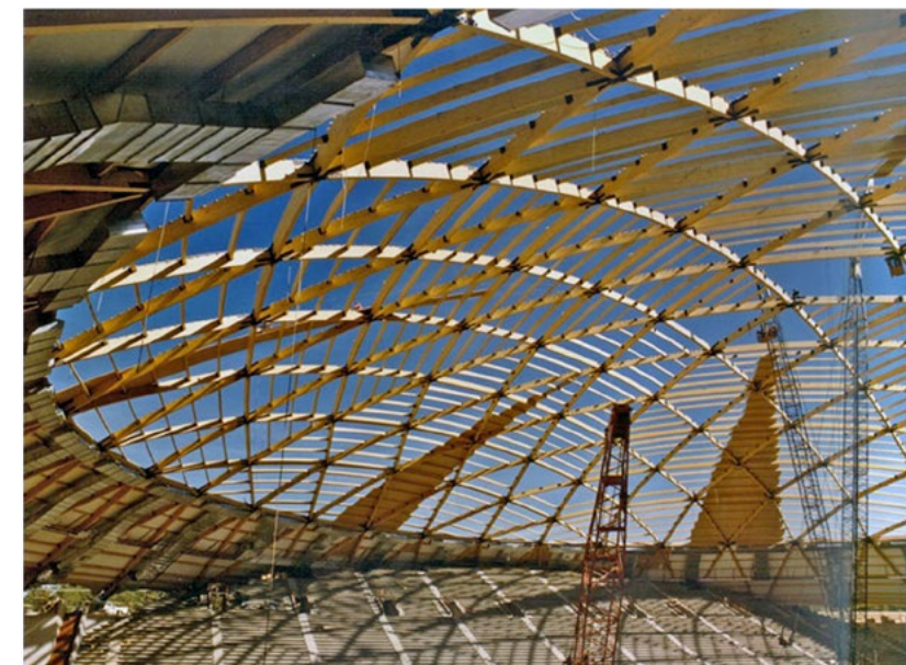
Obr. 13: Montáž zastřešení haly Skydome (kopule) v roce 1977, průměr 153 m, 1977, Flagsaff, Arizona, USA
