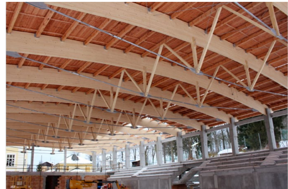
Obr. 8: Multifunkční hala v Kašperských horách (realizace 2015) - lepené obloukové vazníky s ocelovým táhlem a s dřevěnou vzpěrou.
