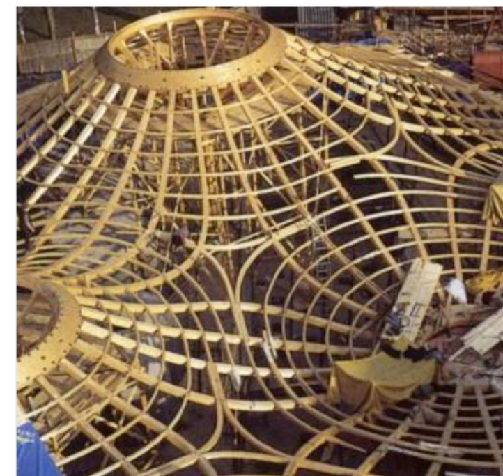
Obr. 17: Žebra dřevěné střešní konstrukce konstrukce - Bad Dürreheim
