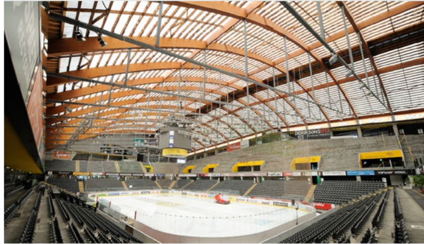
Obr. 10: Zimní stadion v Bernu - PostFinance Arena, parabolický dvoukloubový oblouk s ocelovým táhlem
