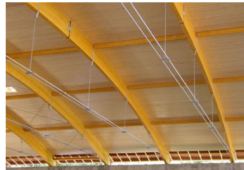
Obr. 9: Zimní stadion ve Zlíně - lepené dřevěné obloukové vazníky s dvojicí ocelových táhel
