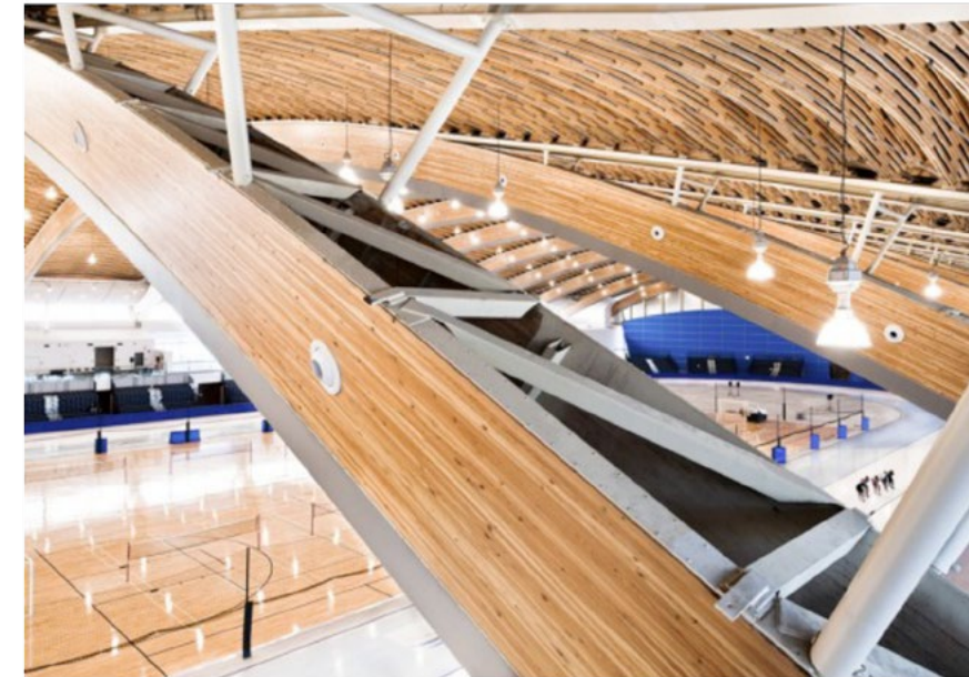
Obr. 12: Detailní pohled na kombinovanou konstrukci nosníků
