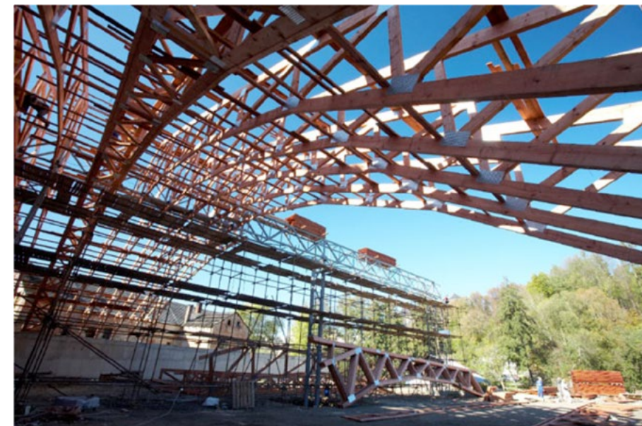
Obr. 4: Zastřešení tenisové haly v Turnově - dřevěná příhradová konstrukce s ocelovými styčnickovými deskami s prolisovanými trny
