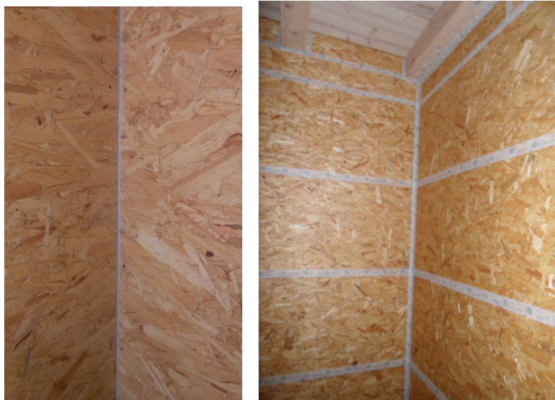
Obr. 1 Správné spojení OSB pomocí tmelů či speciálních těsnících pásek (foto: autor)
