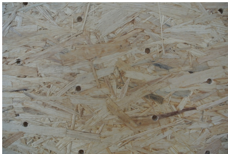
Obr. 2 Perforovaná OSB dle CZ UV 27796 a SK UV 7346 (foto: autor)
